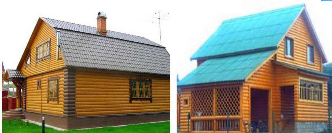
Рис. 1. Обшивка фронтонов и стен длинномерным материалом
